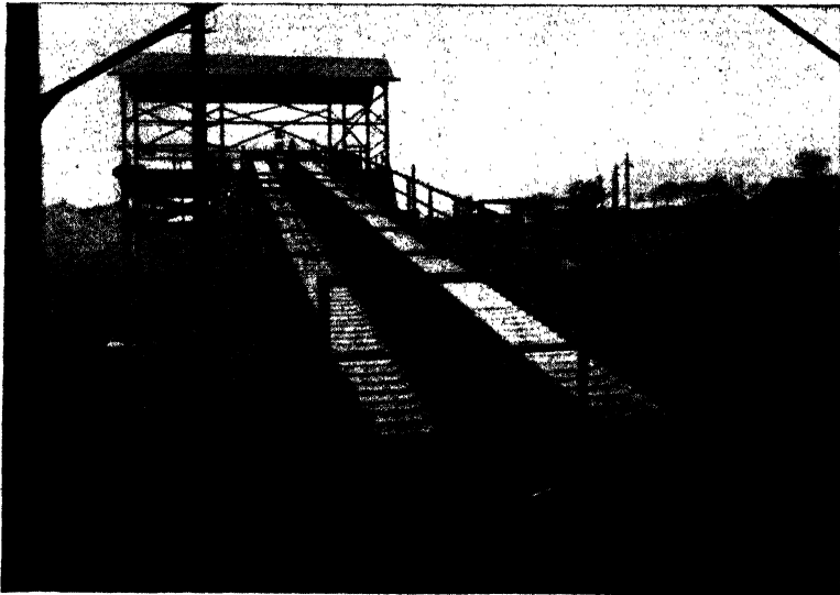
FIG. 7.—Machine Casting of Pig Iron.
