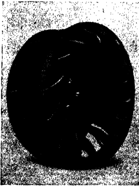
Fig. 11.—Francis turbine impeller
