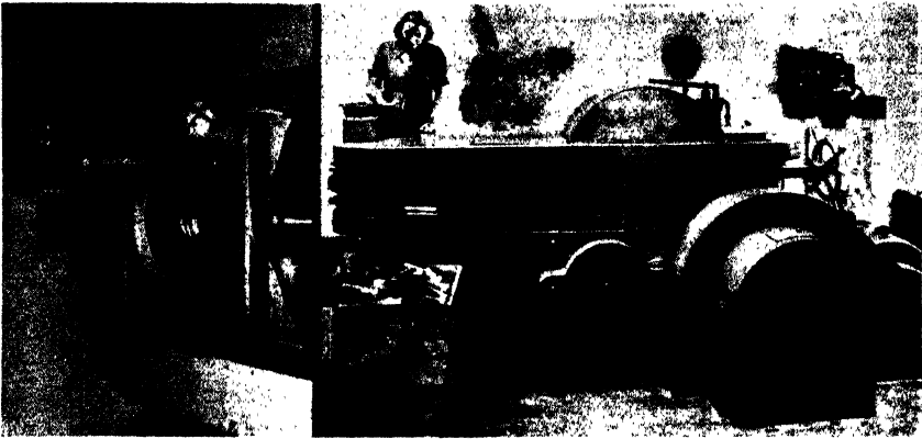
Fig. 254. Impact extrusion machine (von Roll).
