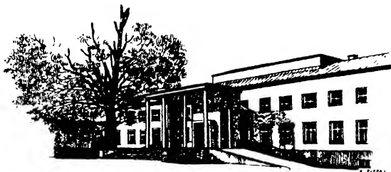
Bad Ischl, Kurmittelhaus
