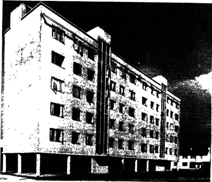
FIG. 18.—FLATS AT WALTHAMSTOW, LONDON.
