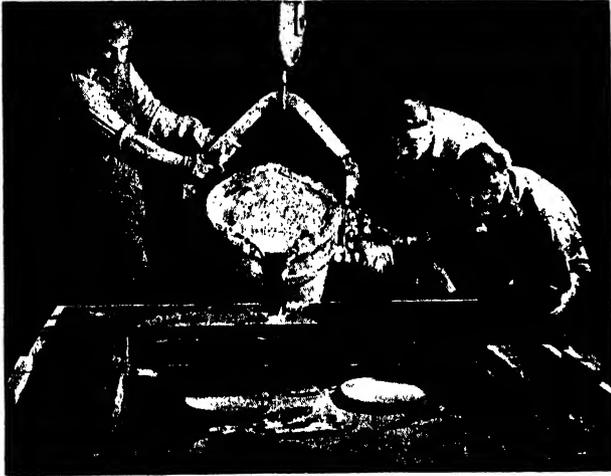
Fig. 387. Pouring a die in an earthen mold
