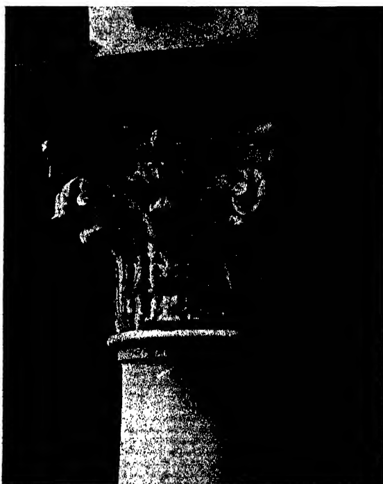
FIG. (B), above.—Scuola di S. Marco, Venice. A Corinthianesque pilaster capital, architrave, and frieze.
