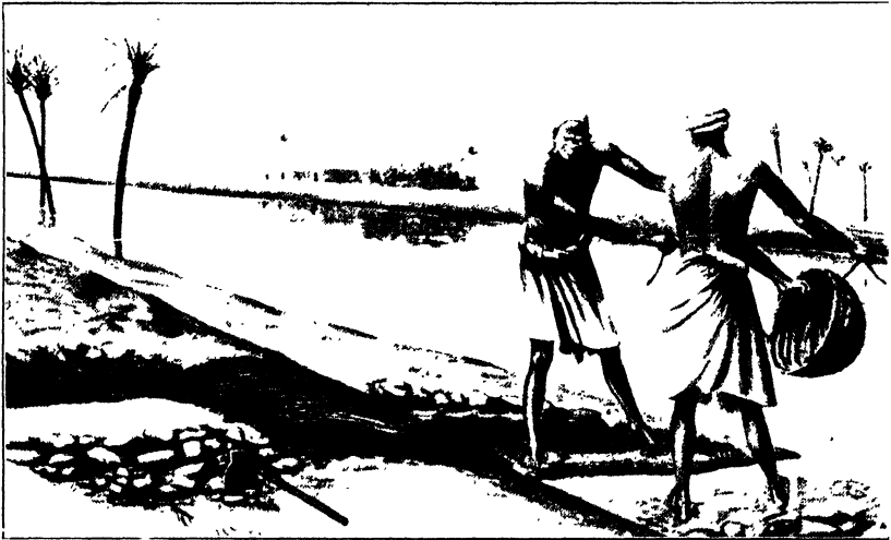
FIG. 30. — The Natali, or swinging basket. (U. S. Dept. Agr. O. E. S. Bul. 130.)
