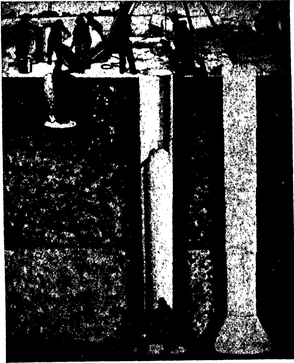
FIG. 15.—Gow caisson piles.
